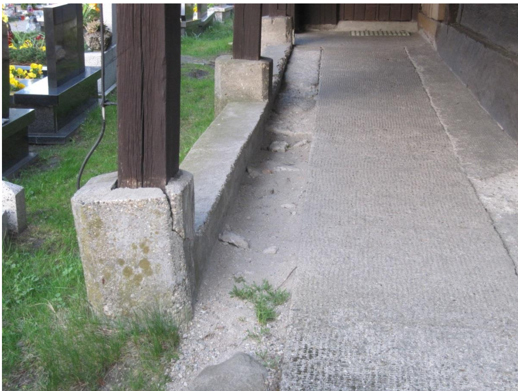
Fot. 15. Betonowa nawierzchnia przed przedsionkiem
