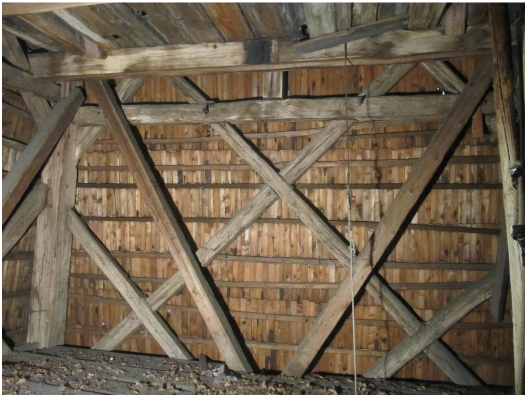
Fot. 10. Konstrukcja ścian wieży
