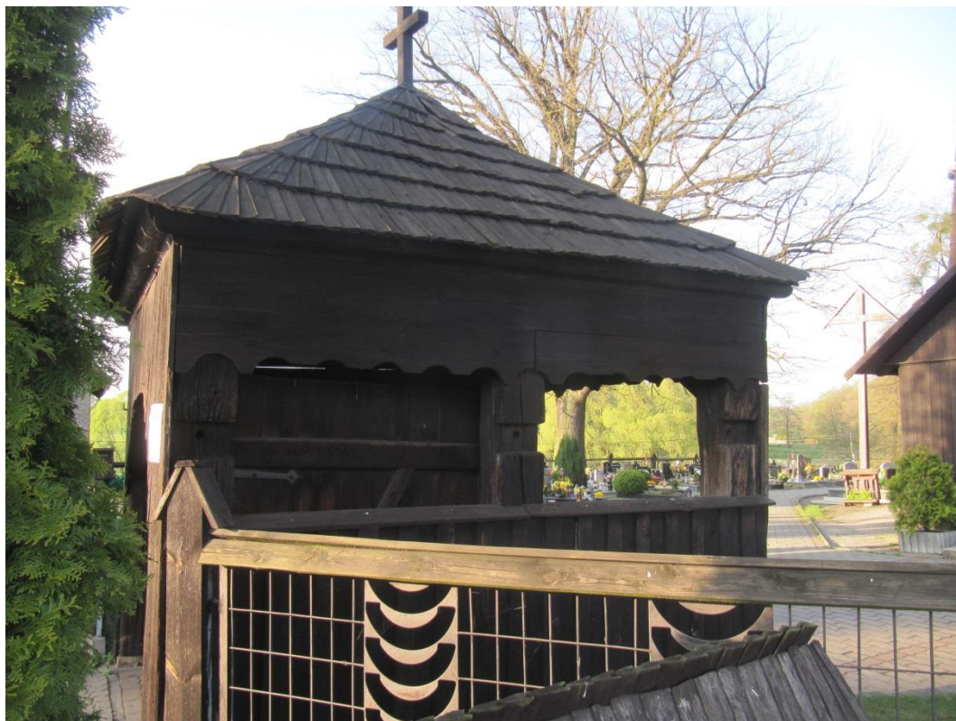
Fot. 29. Skrzydło drzwi w bramce
