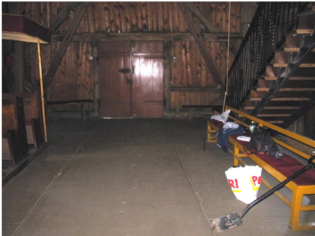
Fot. 14. Betonowa posadzka w kruchcie
