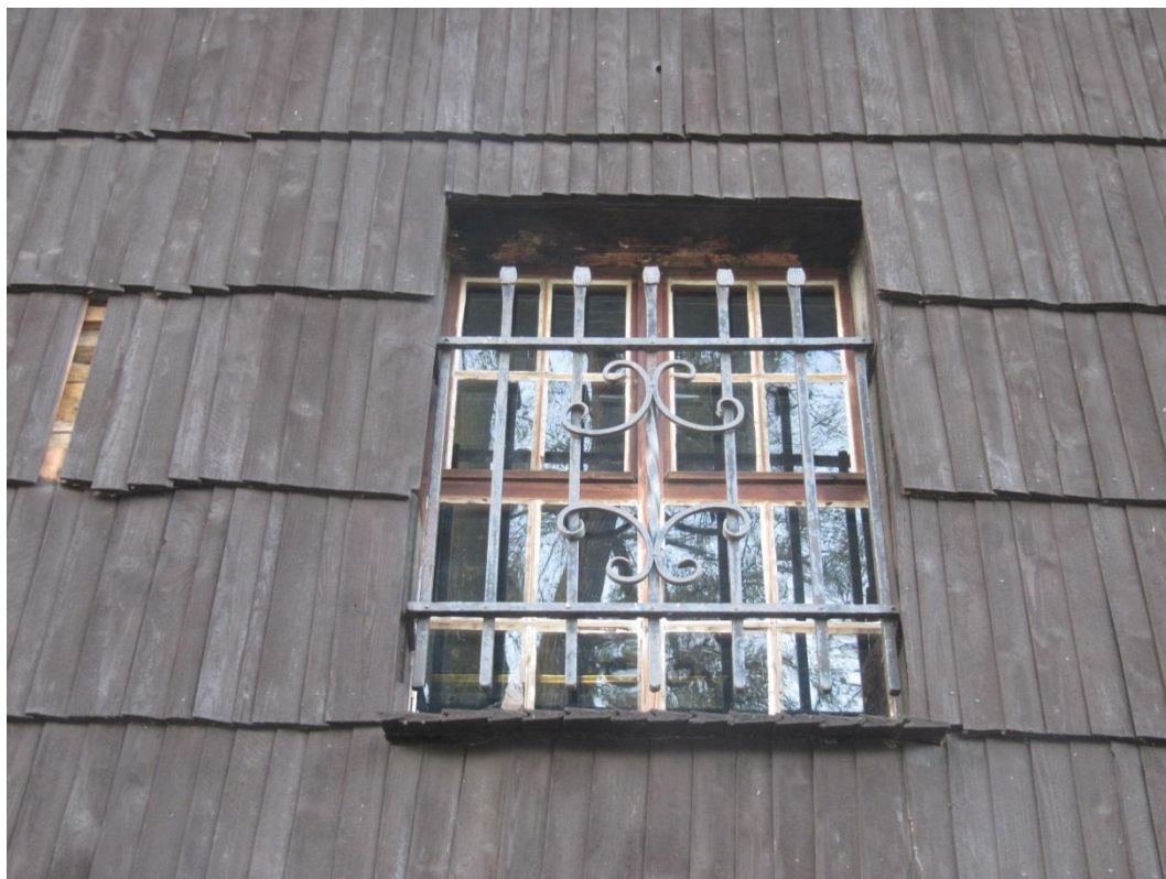
Fot. 23. Okno w nawie za chórem; elewacja południowa
