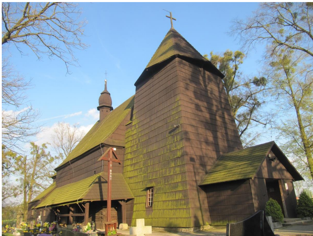
Fot. 1. Widok kościoła – elewacja północna i zachodnia
