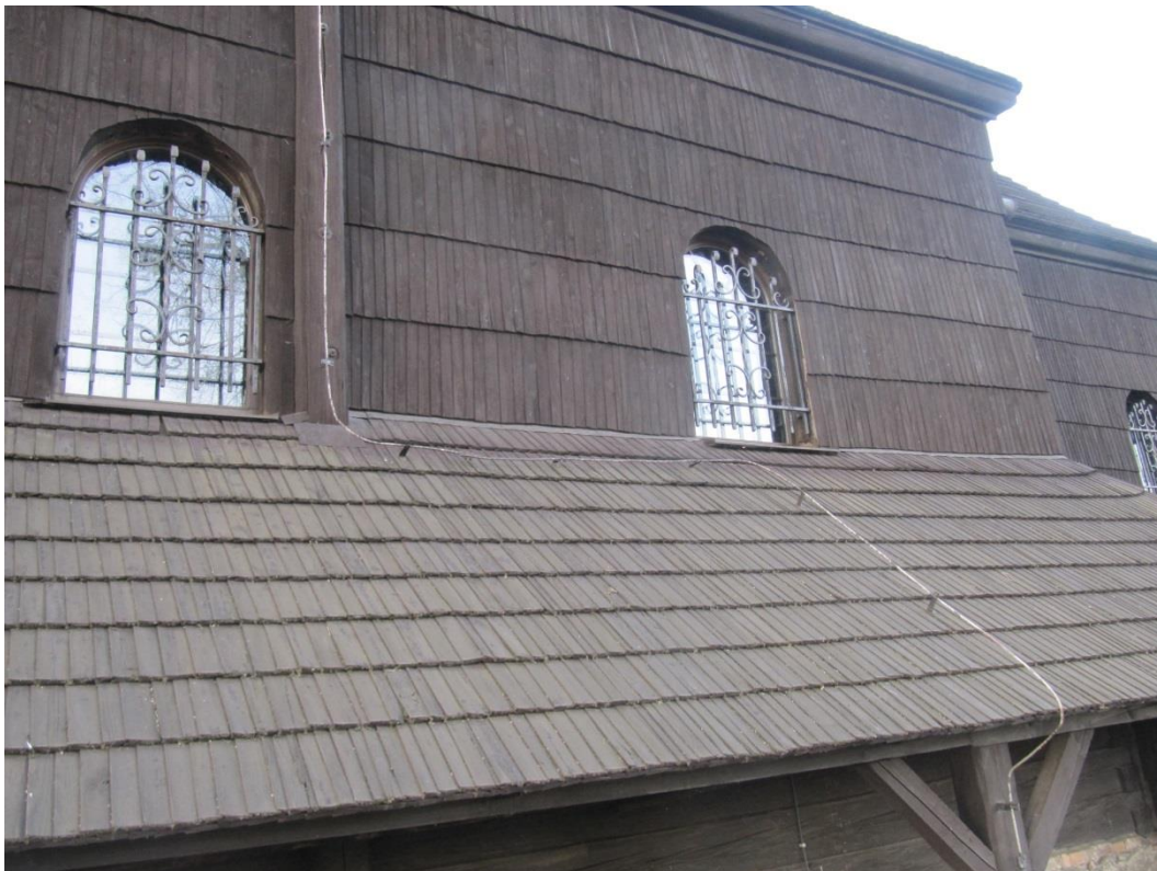
Fot. 20. Okna w nawie i prezbiterium na elewacji południowej
