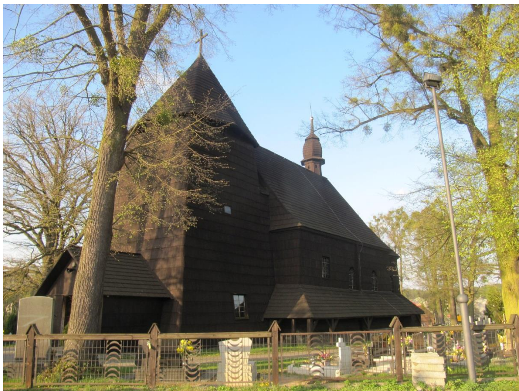
Fot. 2. Widok kościoła – elewacja południowa i zachodnia
