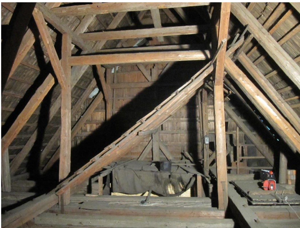
Fot. 12. Konstrukcja więźby nad nawą
