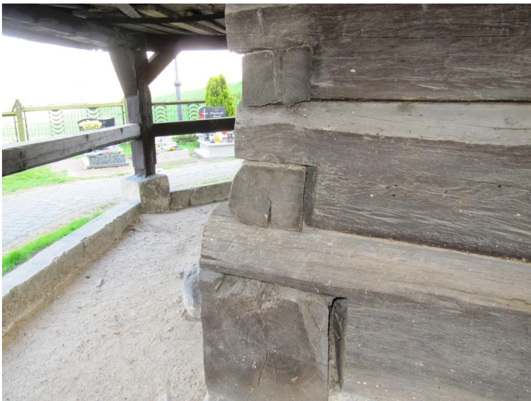
Fot. 25. Nawierzchnia gruntowa pod sabotami za prezbiterium
