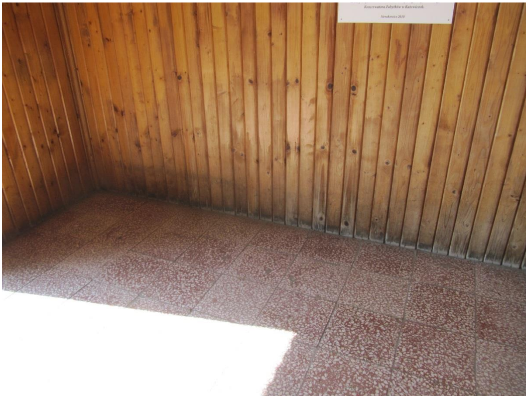
Fot. 16. Posadzka z płytek lastrykowych w otwartym przedsionku przed kruchtą
