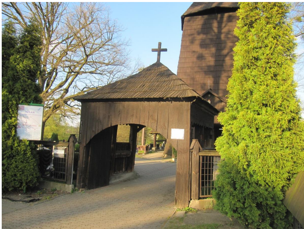
Fot. 3. Bramka przy ogrodzeniu
