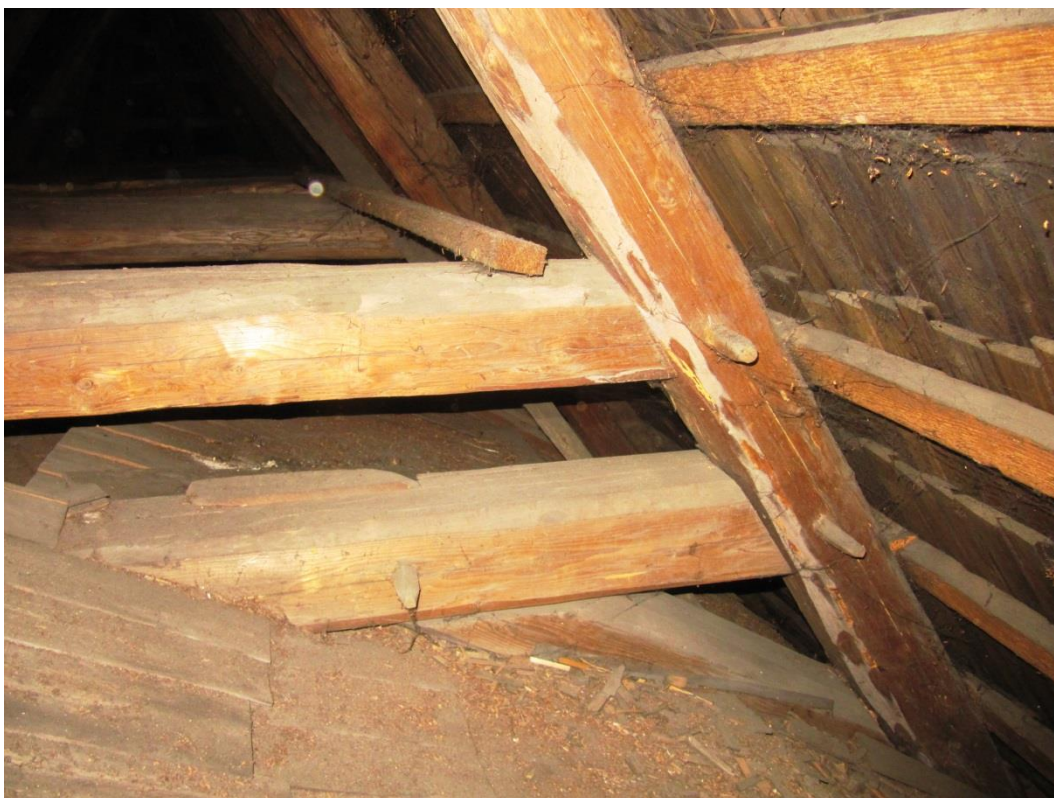
Fot. 14. Stan konstrukcji 2-jętkowych dźwigarów nad prezbiterium
